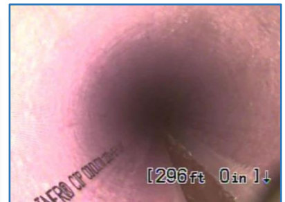
5 inch ID conduit shown with CIP-Conduit® liner installed
